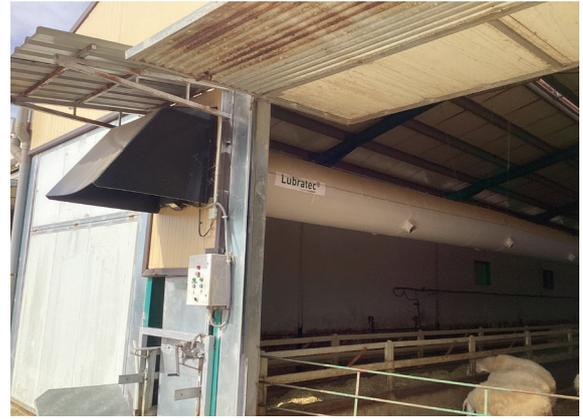
Imagen 2. Sistema de impulsión de aire Lubratec® instalado encima de las cintas de alimentación en la Nave 2 de Ovicanos SC.
