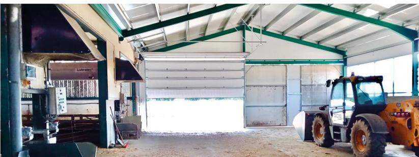
Imagen 5. Puertas automáticas para optimizar el manejo de entrada y salida de las diferentes maquinarias en las instalaciones.
