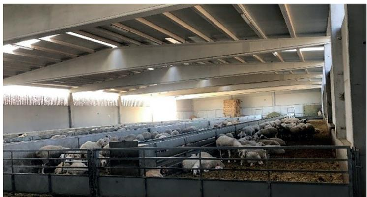
Imagen 4. Nave con una anchura superior de 20m dificultándose su ventilación lateral: un viento entre 2-4m/s no es capaz de atravesarla arrastrando el aire viciado en su totalidad y con mayor velocidad se pueden producir corrientes que afectan al bienestar y salud de los animales.
